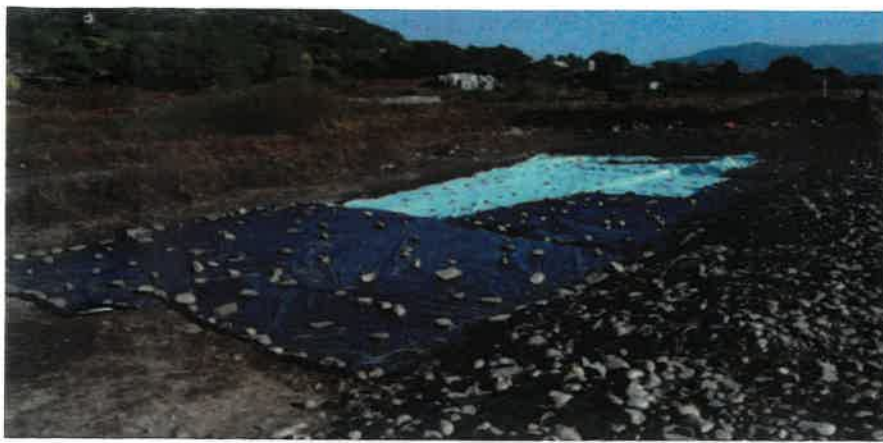
Protección e tapado manual da escavación en area, estado final
